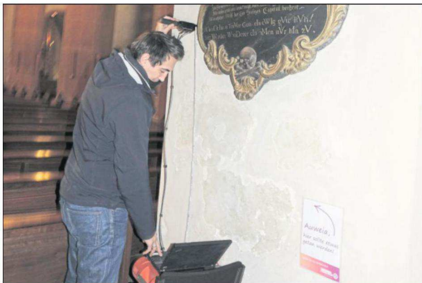
DER SALZGEHALT in den Mauern ist extrem hoch. Das Messgerät war an einigen Stellen teilweise überfordert.
